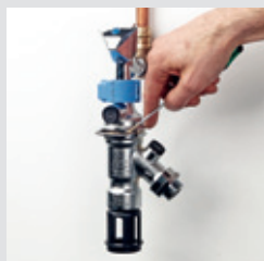
2. Halteklammer mit einem Schraubenzieher herausziehen
